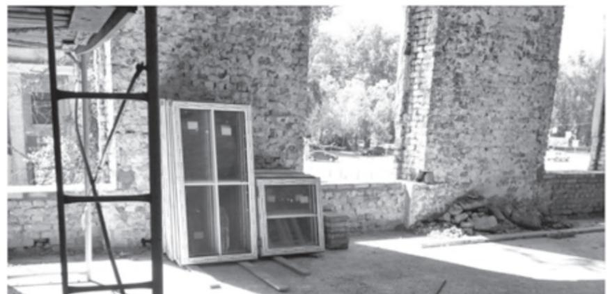
Сегежская библиотека вернется в свое историческое здание в следующем году. Сейчас подрядчик готовит чердачное перекрытие здания к бетонированию, восстанавливает кирпичную кладку парапета и оконных четвертей, монтирует окна. Также монтируют наружные сети канализации, включая ливневую, из подвала откачивают скопившуюся воду, ведутся другие работы. В здании будет лифт, для его установки устраивают котлован и основание под лифтовую шахту. Всего на объекте работают 18 человек.
