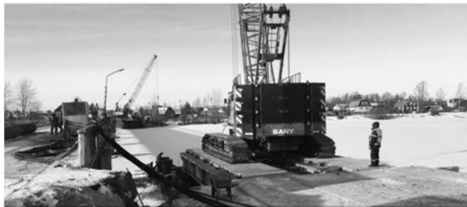
Реконструкция Шуйского моста. Фото: Минтранс РК
